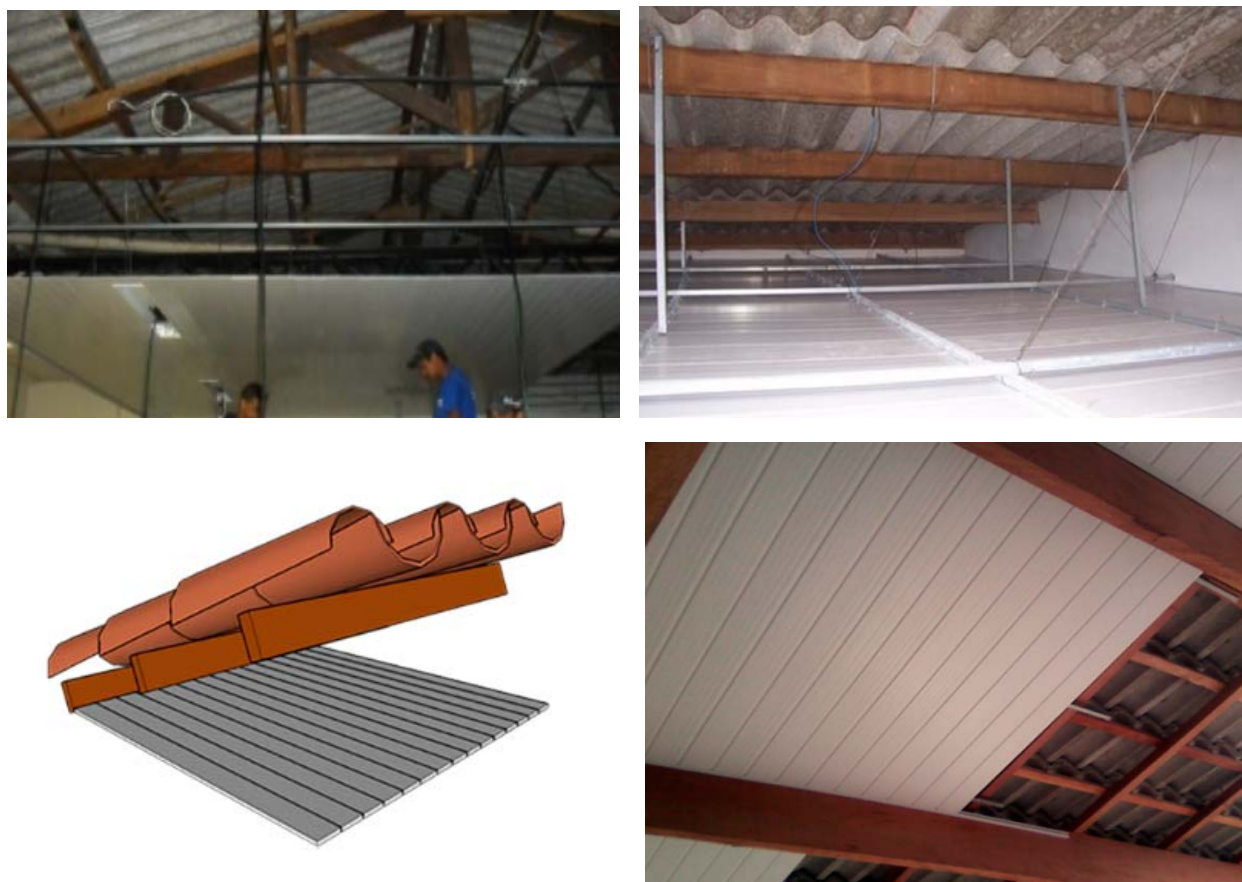
Figura 1 – Fotos de exemplos de sistemas de cobertura com o uso de perfis de PVC para forros.
